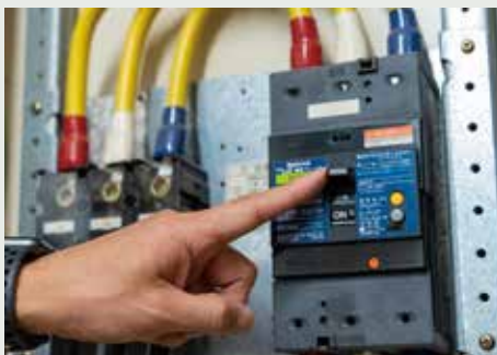
震災後の火災を防ぐため、避難前に必ず電気のブレーカーを切りましょう。
